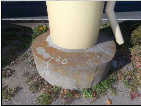
歩道橋橋脚基部の根巻き コンクリートのひびわれや欠損
