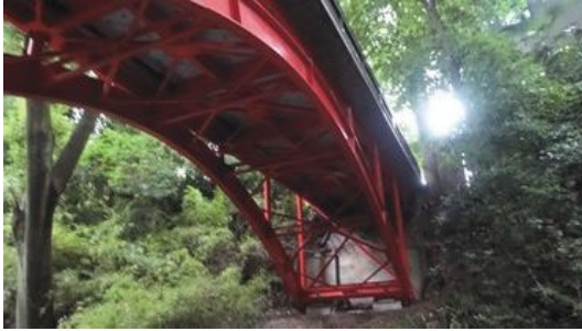
実験対象橋梁桁下状況
