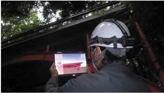
開発したシステムによる点検状況
