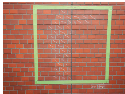
図-4 検査終了後のマーキング状況写真（別館：実施者C）
