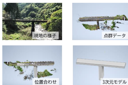
図4 3次元モデルの構築(カメラ搭載 UAV)
