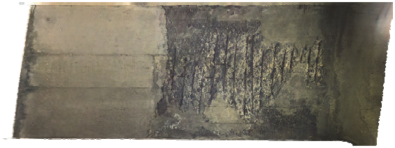
図-6 無名橋床版下面のオルソ画像
