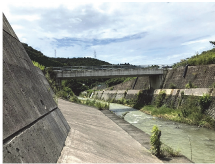
図-3 実証実験フィールド (大阪府童子畑橋 側面写真)
