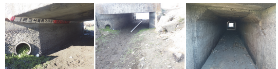
桁下状況(橋梁 1/橋梁 2/橋梁 3)
