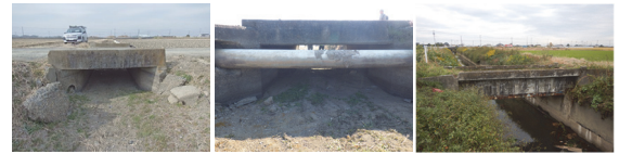
対象橋梁(橋梁 1/橋梁 2/橋梁 3)
