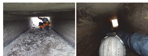
図-1 小規模橋梁における点検作業状況
