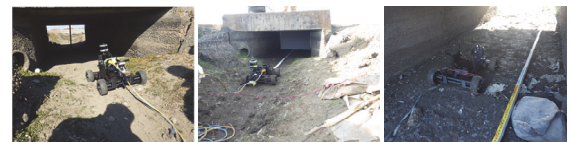
資材設置状況(スタッフ/白線/エスロンテープ)
