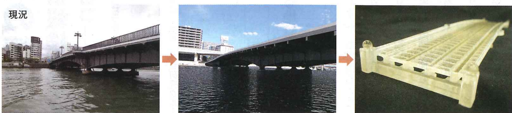
図2 竣工時の周辺環境の把握として実施した事例
